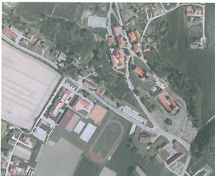
Slika 4.7: Kotlovnici v OŠ Velika Nedelja in poslovno stanovanjskem objektu Mihovci.
