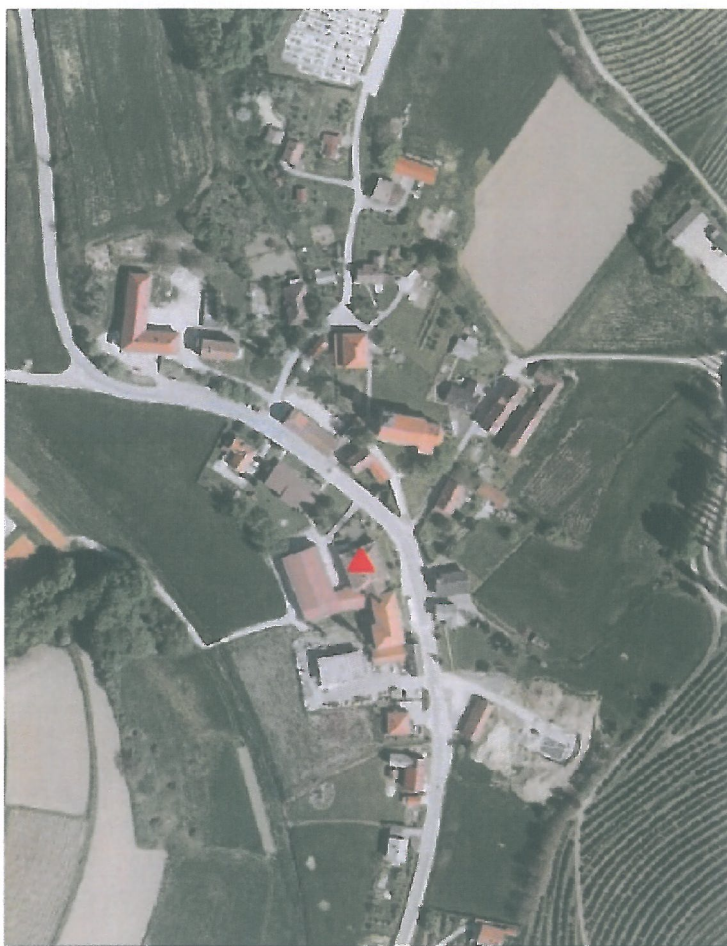
Slika 4.10: Kotlovnica v OŠ Miklavž pri Ormožu.
