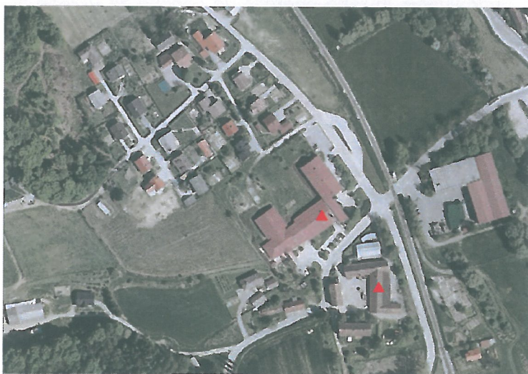
Slika 4.9: Kotlovnici v podjetju P&F Jeruzalem Ormož d.o.o., Trsničarstvo Ivanjkovci in OŠ Ivanjkovci.
