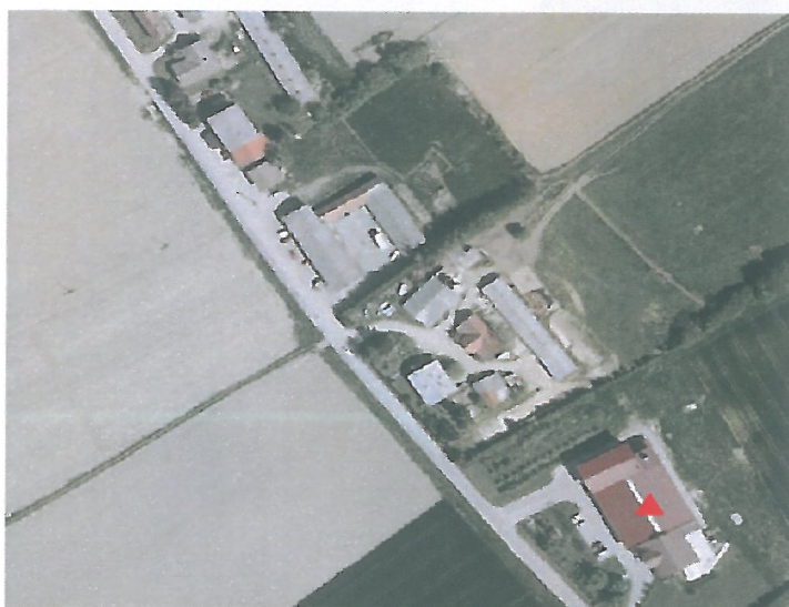
Slika 4.8: Kotlovnica v podjetju TAP Mlinarič d.o.o.
